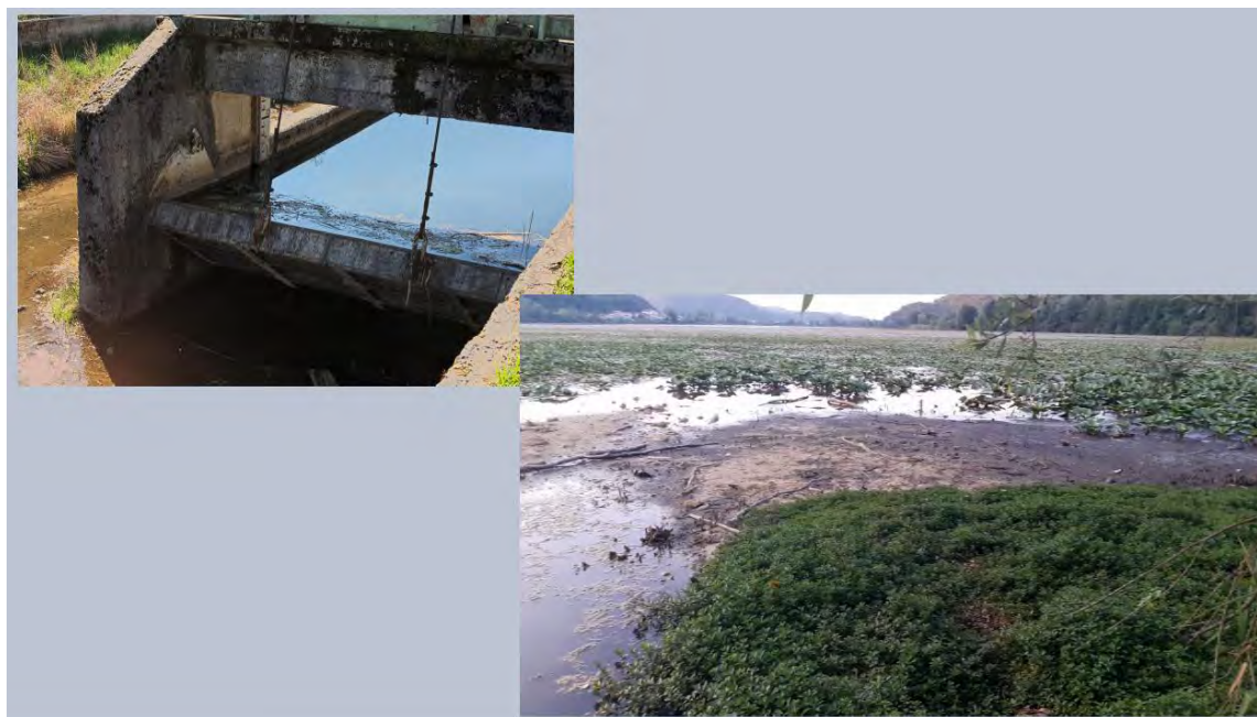
Fig. 11 Sopra: a sx la chiusa regolabile del lago costruita negli anni 60. A dx un'immagine testimonia le conseguenze di un consistente prelievo del volume d'acqua (-50cm sul livello medio): tutta l'area inquadrata in una situazione di normalità sarebbe sommersa d'acqua.
